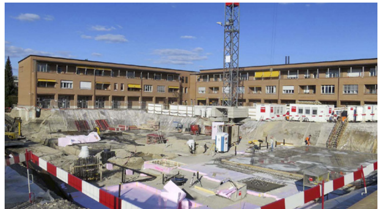
Das Fundament des Nägelihofs steht. (Foto zvg)
